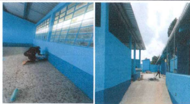
Foto 10: Pintura en muros interiores y exteriores.
