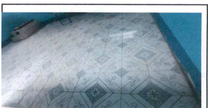
Foto 6: Aplicación de piso en la cocina.
