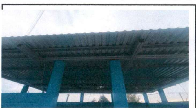
Foto 4: Sustrución de techo de lámina por lámina troquelada aluzinc.
