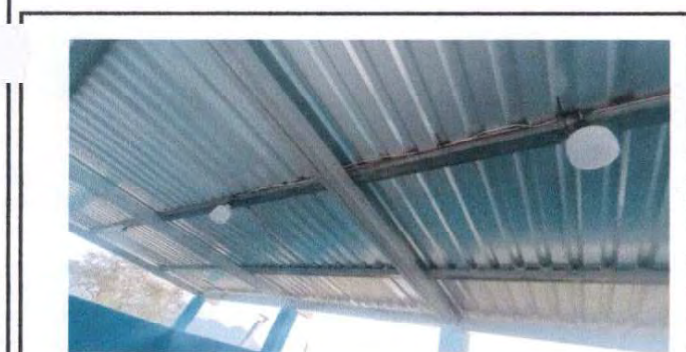
Foto 5: Instalación de la red de electricidad en el aula No. 3
