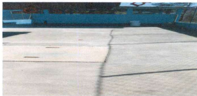
Foto 8: Colocación de torta de cemento.
