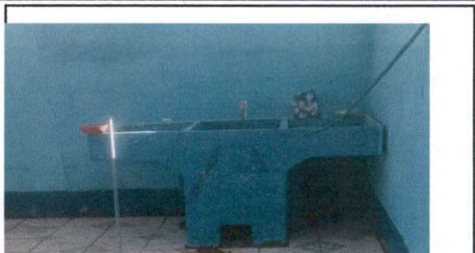
Foto 2: Sustrución de pila de cemento de dos lavaderos
