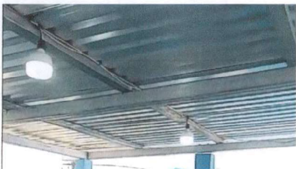
Foto 9: Reparación de sistema eléctrico en la cocina
